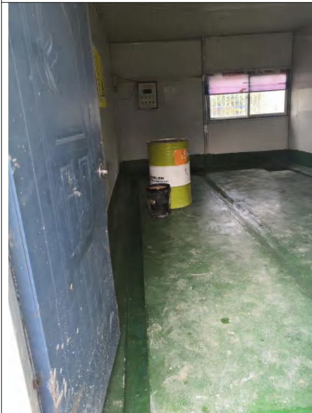
危废间建设情况
